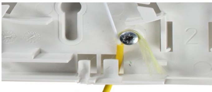
Bild 9: Zugentlastung über Aramidfaser
